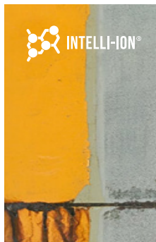
Décapé avec du solvant
